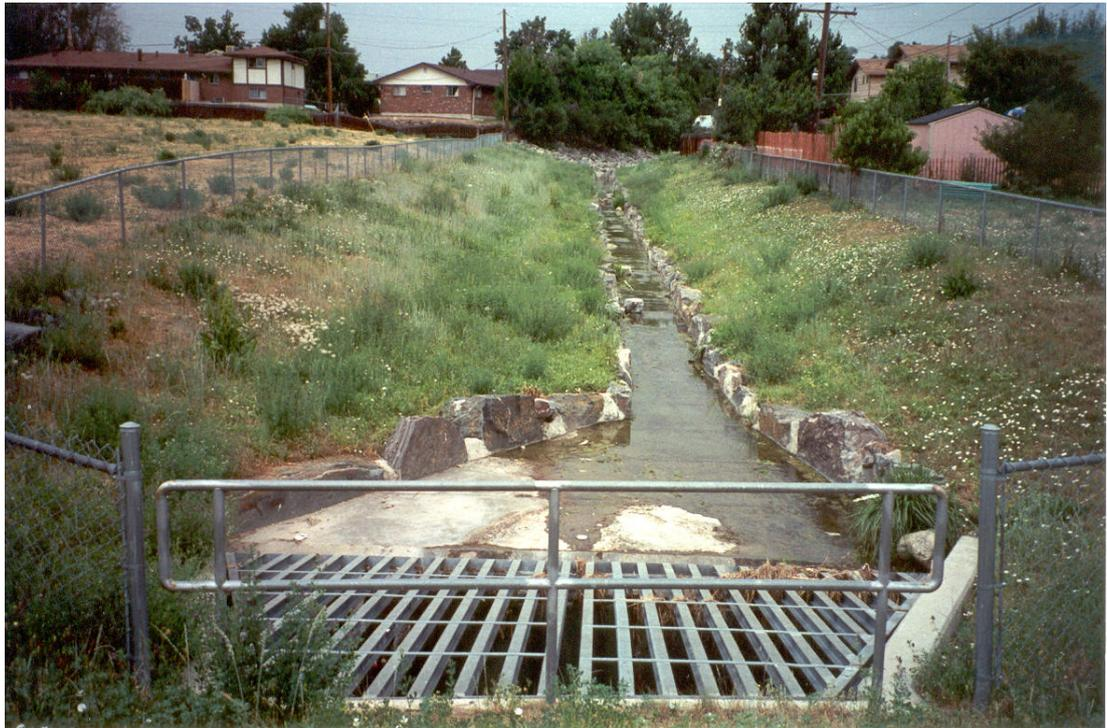
Figura 1 – Detalhe de estrutura da saída em área de reserva de água de escoamento superficial. Trata-se de um reservatório pequeno - Denver, Estados Unidos.
