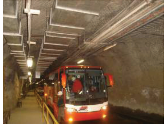
Figura 2 – Interior da mina – área de concentração de umidade
